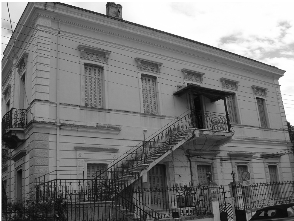
Εικ. 7. Υφιστάμενη κατάσταση: δυτική όψη
