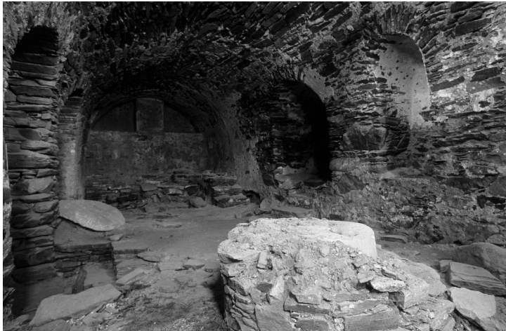
Εικ. 5. Το λιοτρίβι στη στάθμη του υπογείου
