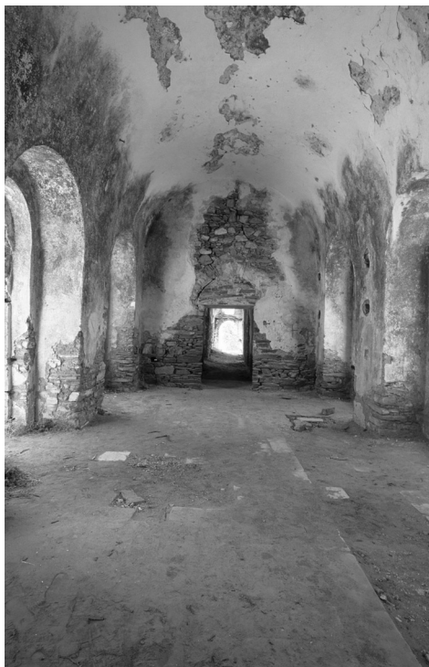
Εικ. 4. Η μεγάλη αίθουσα του κυρίως κτιρίου στη στάθμη του ισογείου
