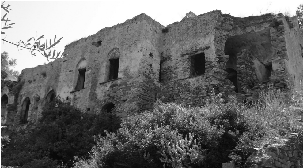
Εικ. 8. Τμήματα που έχουν καταρρεύσει στη δυτική όψη
